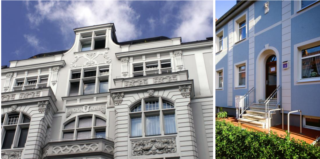
Abbildung 58: Mittels Innendämmsystem sanierte Jugendstilfassade (links), Mittels WDVS saniertes Stadthaus (rechts) (Bildnachweis: Fachverband Wärmedämm-Verbundsysteme E.V.)
