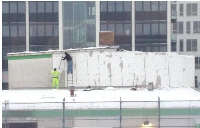
Abbildung 63: Abschälen der Putzschicht mit einem Eisschaber, Gräfelting 2013 (Quelle: FIW München)
