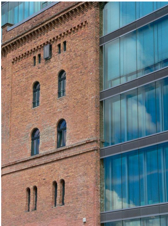
Abbildung 96: Mittels Innendämmsystem saniertes ehemaliges Fabrikgebäude mit umgewidmeter Nutzung (Bildnachweis: Fachverband Wärmedämm-Verbundsysteme E.V.)
