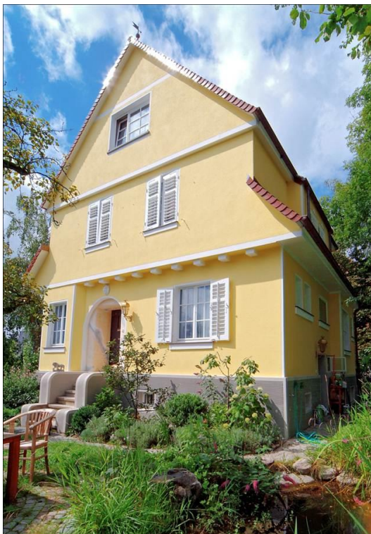
Abbildung 94: Mittels WDVS sanierte Fassade eines EZFH (Bildnachweis: Fachverband Wärmedämm-Verbundsysteme E.V.)
