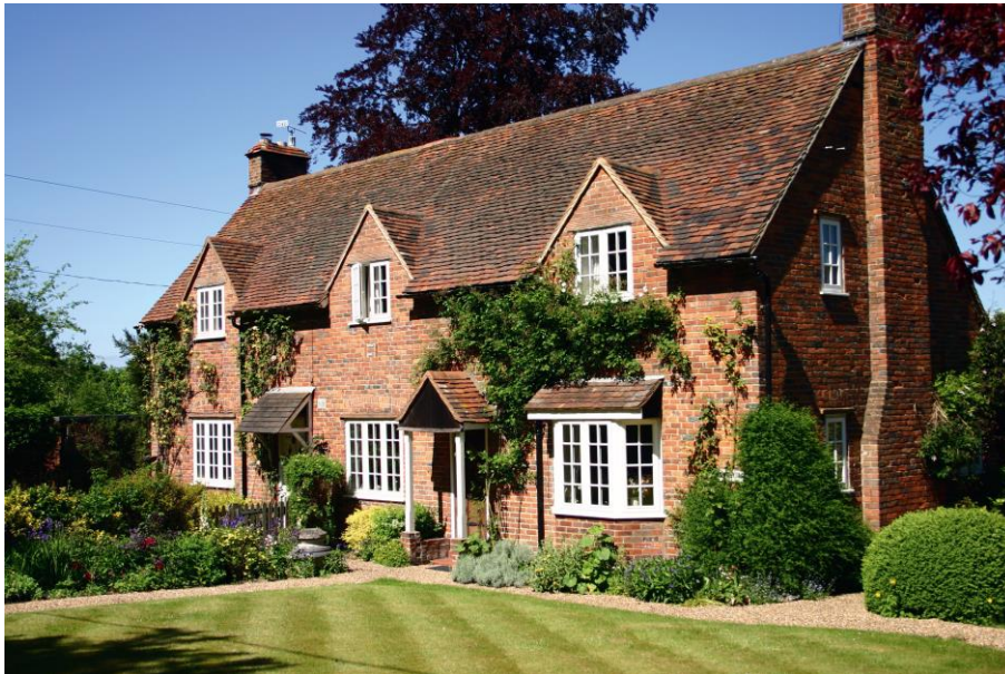
Abbildung 95: Mittels Innendämmsystem saniertes EZFH (Bildnachweis: Fachverband Wärmedämm-Verbundsysteme E.V.)
