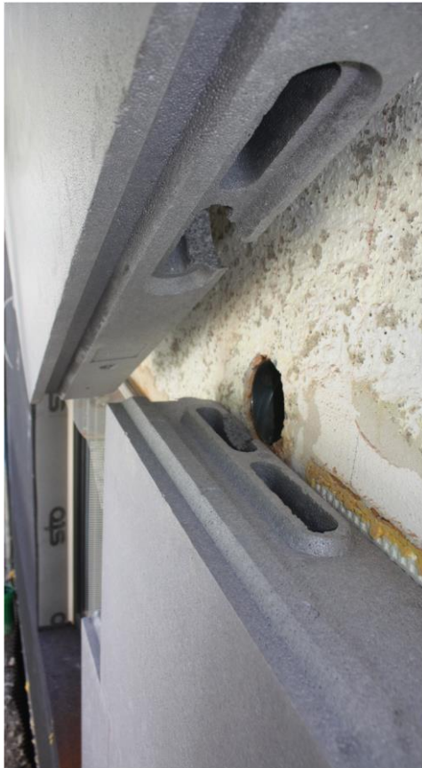
Abbildung 48: FAW: Anschluss der EPS Dämmplatte mit den integrierten Lüftungskanälen an die Luftzuführung in das Gebäude.
