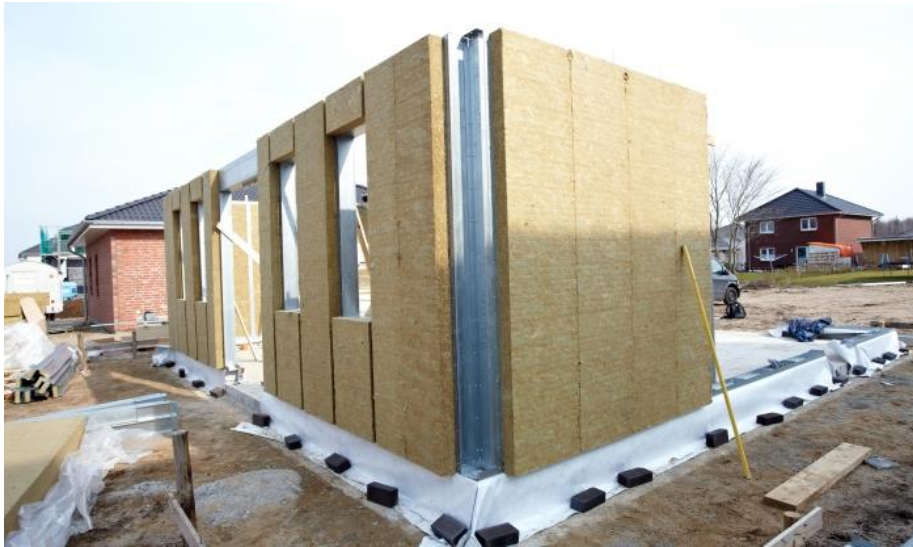
Abbildung 46: Modulares Wandbausystem mit Mineralwolleplatten (RockShell, Rockwool)
