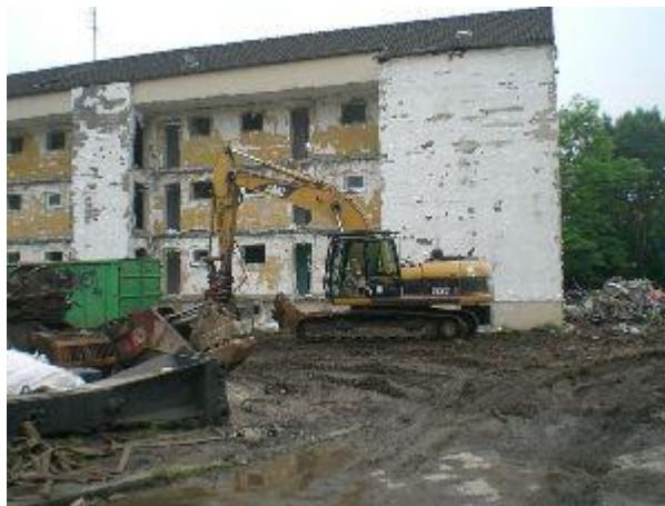
Abbildung 62: Abbruch Übergangwohnheim Dortmund 2009 Quelle: Carsten Hördemann http://forum.bauforum24.biz
