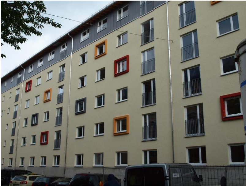
Abbildung 93: Mittels WDVS sanierte Fassade eines MFH im modernen Stil
