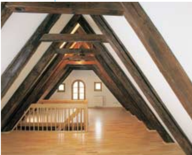
Bild 17: Sichtbare Dachkonstruktion mit einer Wärme- dämmung aus PUR-Hartschaum, WLG 025
