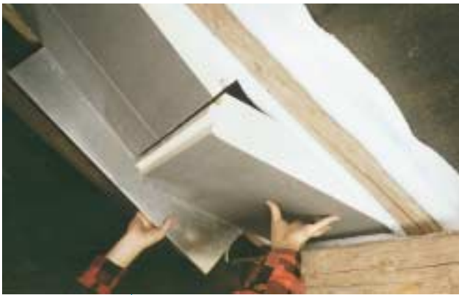
Bild 20: Wärmebrückenfreie Zwischensparren- dämmung mit einem PUR- Hartschaum- Dämmsystem
