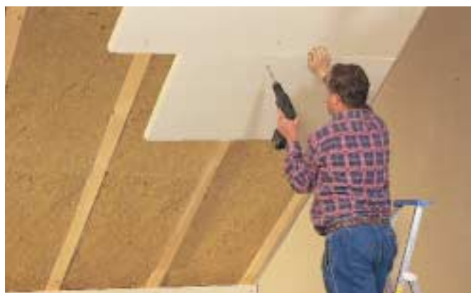
Bild 18: Dämmung unter den Sparren mit PUR-Hartschaum, WLG 025
