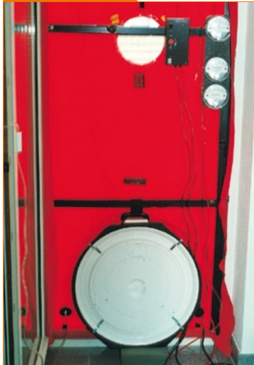
Einbau des Blower-Door-Ventilators und der Messeinrichtung
